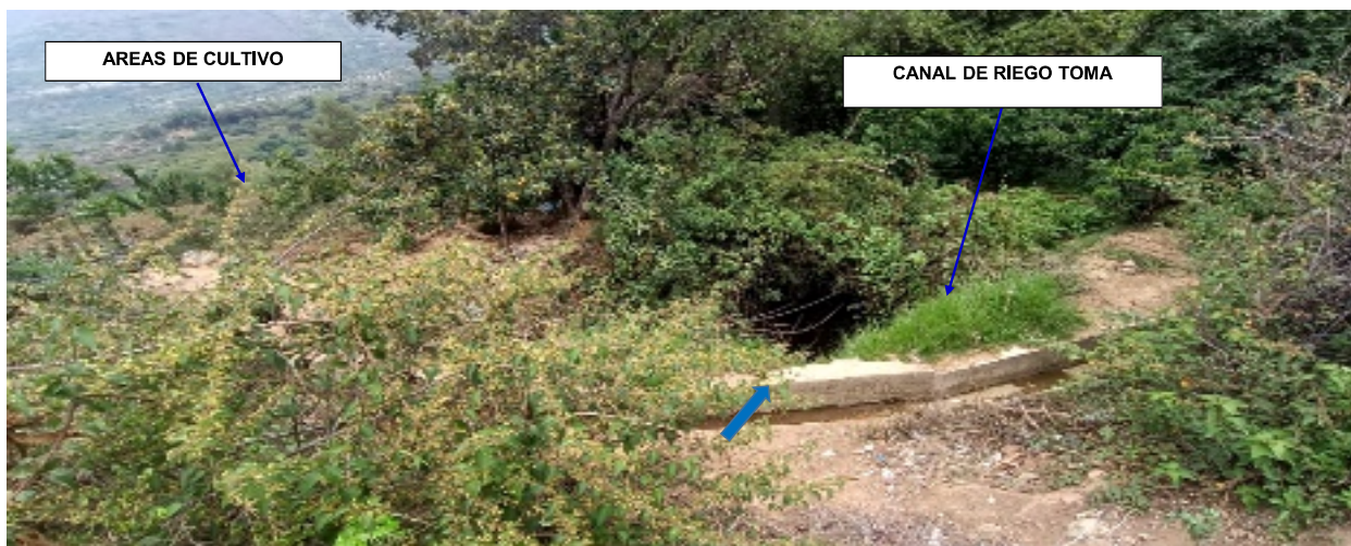
FIGURA N°04: QUEBRADA YUPANCA SE ENCUENTRA COLMATADO, CON EVIDENCIA DE QUE EL CAUDAL PUEDE COLAPSAR HACIA LA MARGEN IZQUIERDA, ES DECIR, HACIA LAS AREAS DE CULTIVO DE LA COMUNIDAD CAMPESINA DE SUMBILCA.
