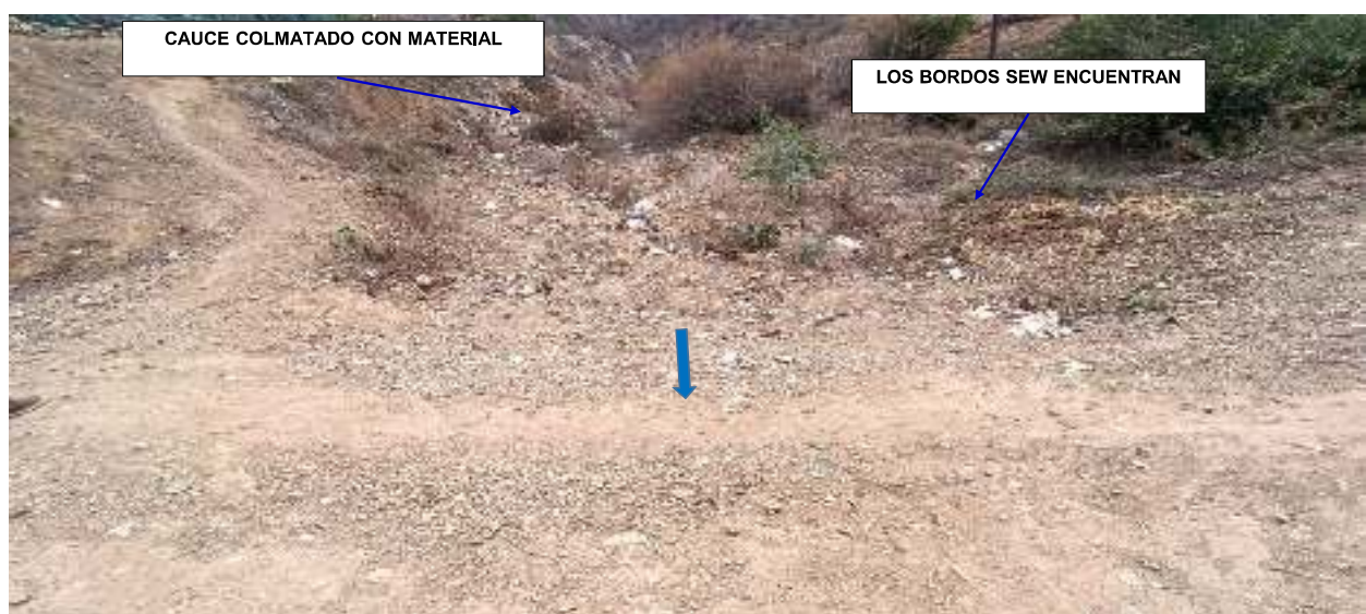
FIGURA N°02: CAUCE COLMATADO CON MATERIAL DE FLUJO DE DETRITOS, PONIENDO EN RIESGO A DESBORDES HACIA AMBOS LADOS QUE AFECTARIA HA AREAS DE CULTIVO, VIVIENDAS.
