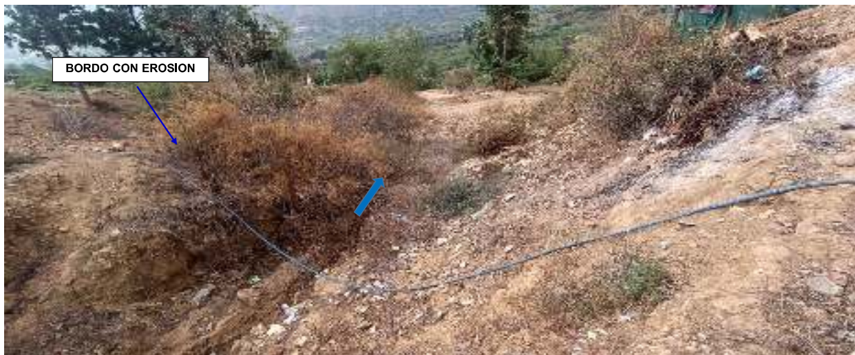
FIGURA N°03: TRAMO DE LA QUEBRADA YUPANCA SE ENCUENTRA COLMATADO CON MATERIAL FLUJO DE DE DETRITOS; EN AMBAS MARGENES SE ENCUENTRA VIVIENDAS Y TRES TROCHAS CARROZABLE QUE DEBEN SER PROTEGIDOS CON LA CONFORMACION DE DIQUES CON MATERIAL PROPIO
